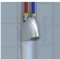
Aufputz-Wasseranschlüsse
